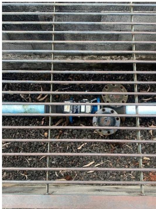
O sistema de abastecimento de água urbano de Catanduvas também conta com uma captação subterrânea por meio de poço artesiano. A vazão de projeto da captação subterrânea é de 3 l/s, no entanto, atualmente a vazão máxima de operação é de 2,2 l/s. A água captada é recalçada diretamente ao R03. O funcionamento do poço acontece prioritariamente em horários da noite e madrugada, principalmente em momentos em que a ETA está desligada, como meio de manter o nível d'água do R03 nestes períodos.
