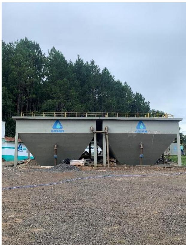
Figura 67: Processo de decantação
