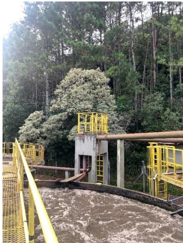
Figura 64: Tanques de aeração.
