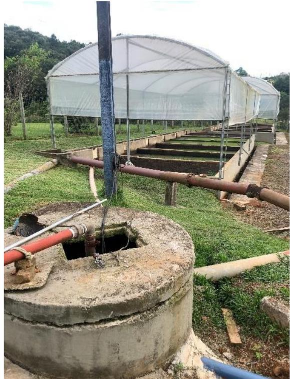
Figura 70: Adensador (em fase de testes).
